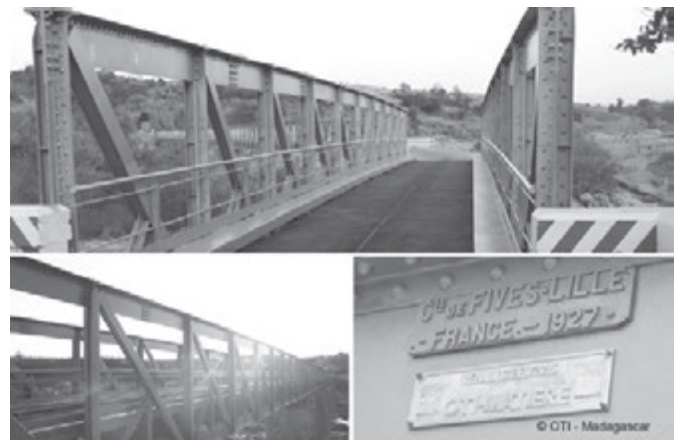
Pont de Betsiboka.
