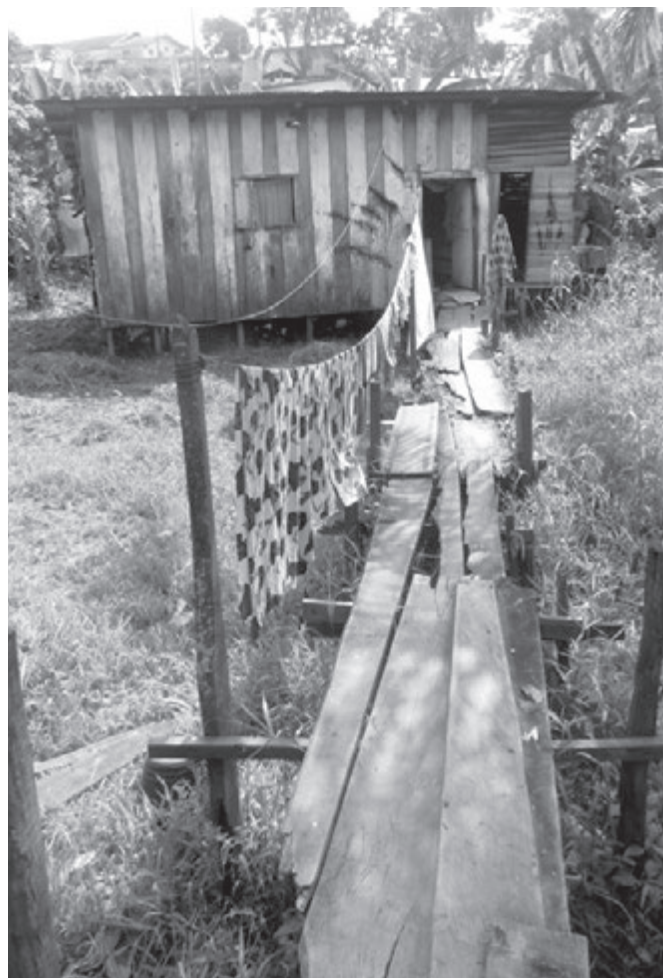
Exemple de technique d'adaptation : maison sur pilotis.
