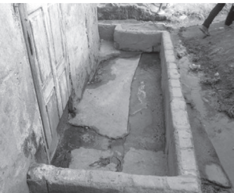
Exemple de technique d'adaptation : véranda surélevée.
