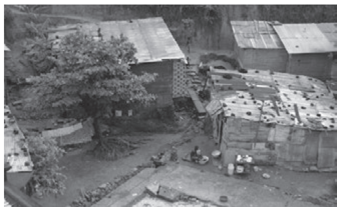
Exemple de constructions informelles dans la ville de Douala.
