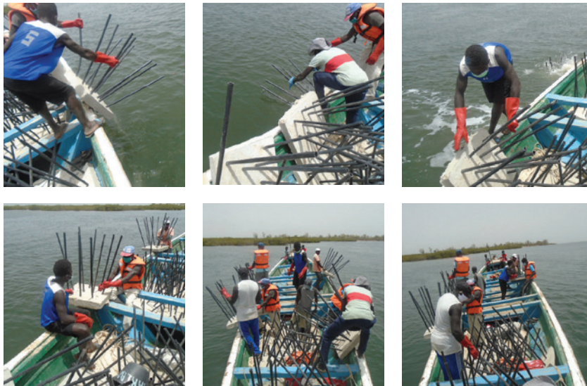
Immersion des modules de récifs artificiels
